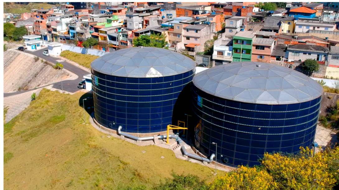
Reservatórios Metálicos – 2 x 6.500m 3
